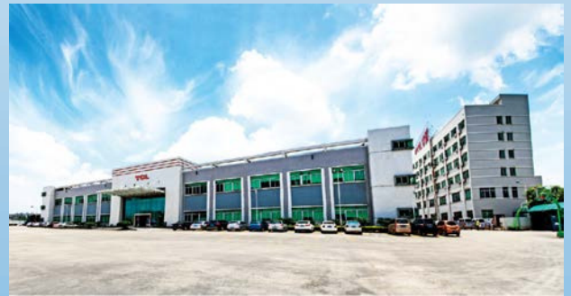
Jiujiang Base (2 εκ. σετ κλιματιστικών)
