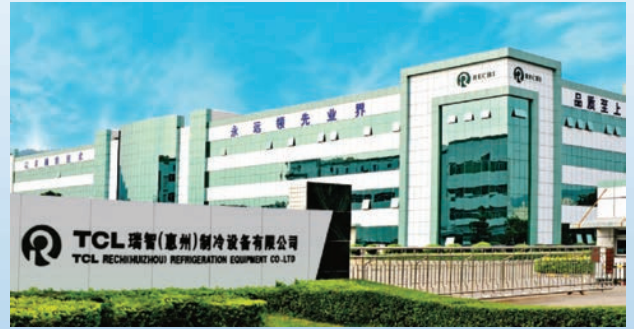
TCL- Rechi Compressor JV (16 εκ. συμπιεστές)
